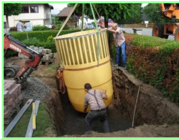
Container einsetzen und ausrichten
