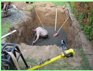
Baugrube 1,8 m tief mit Schotterplanum 0-30
