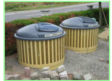
Grube mit Schotter 0-30 auffüllen und Oberfläche herstellen, fertig!
